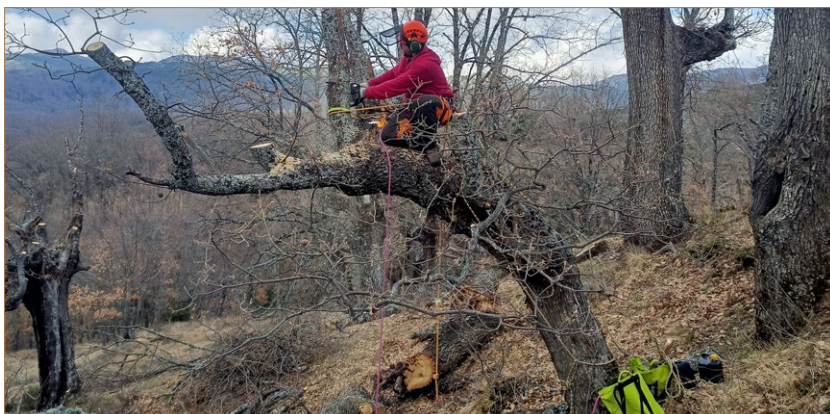
Foto 115. Corte del tocón de la última viga con tensión solamente en la cuerda lateral.
